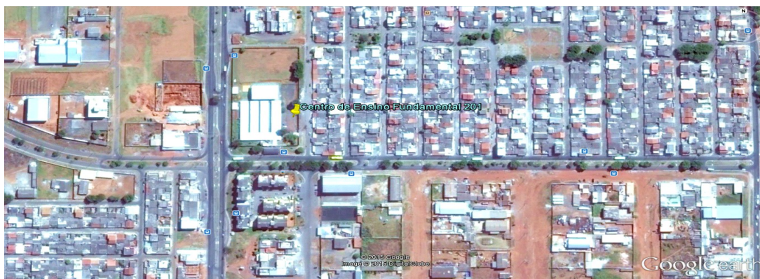
Centro de Ensino Fundamental 201 – Santa Maria – Distrito Federal
